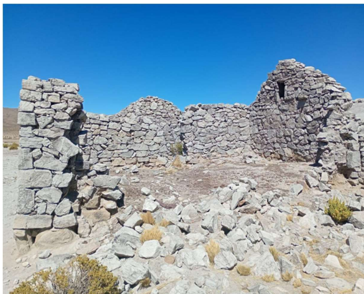
IMAGEN 1: Antigua construcción de piedra (antes del acondicionamiento)
