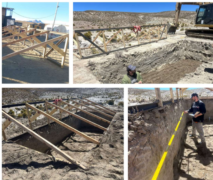
IMAGEN 6: Wallipini. Avance de Obra
