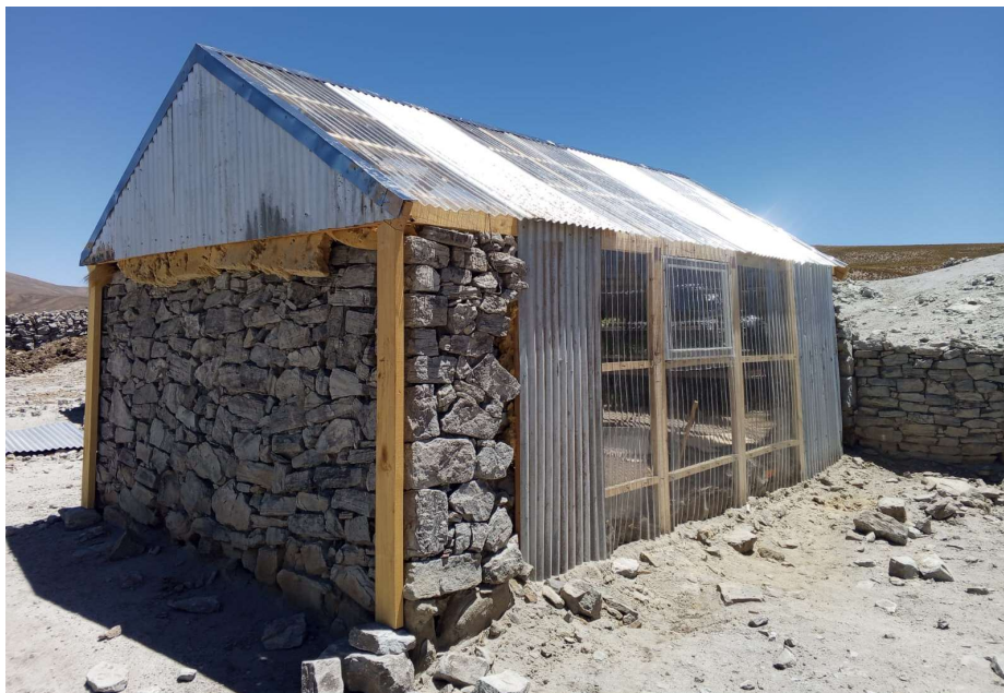
IMAGEN 2: Recinto FVH terminado
